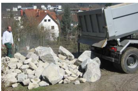
Baubeginn: Steine von Gernot Wewetzer
