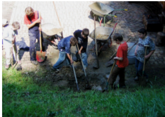
Gemeinsam wird die Brunnenstube ausgehoben
